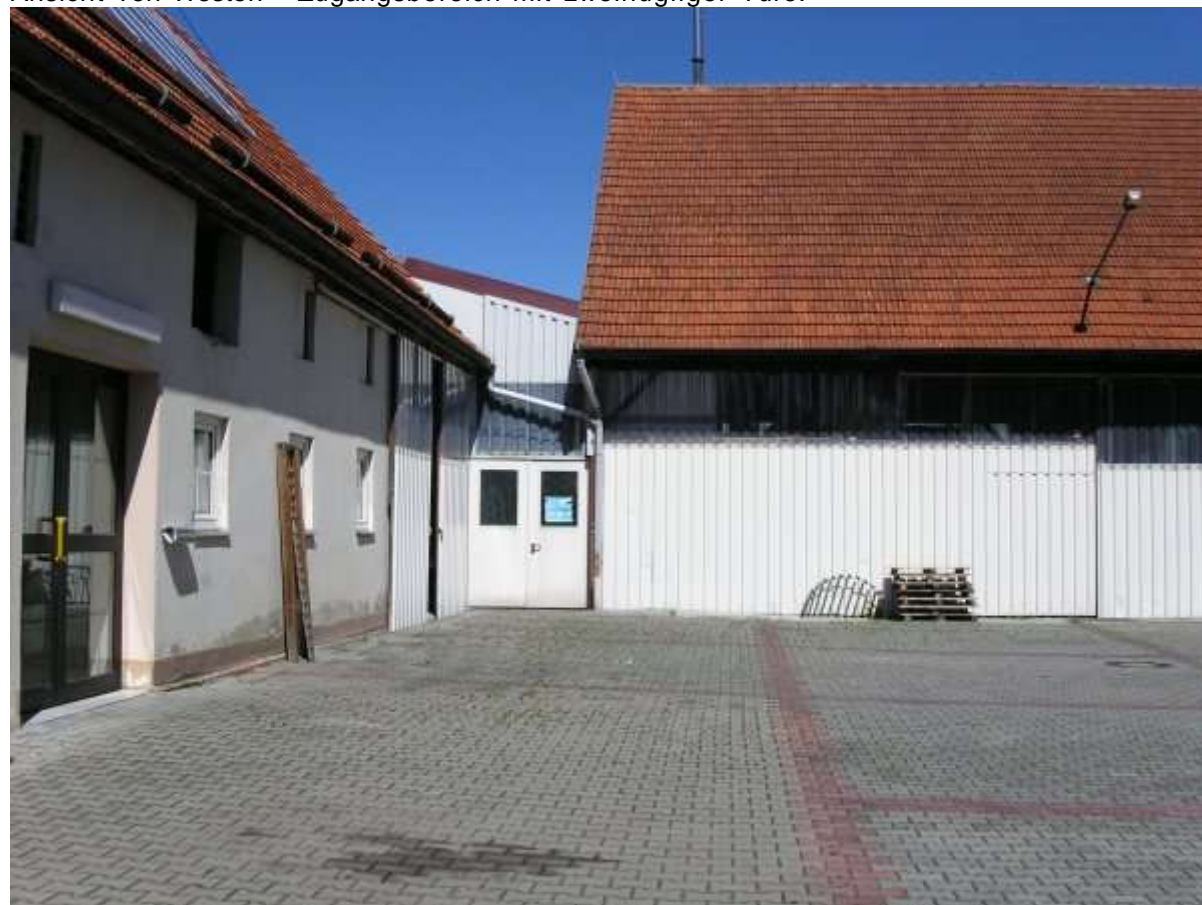
Ansicht von Westen - Zugangsbereich mit zweiflügliger Türe.
